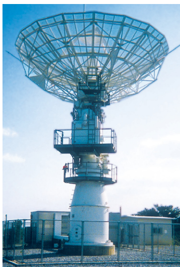
沖縄第1可搬局用パラボラアンテナ
