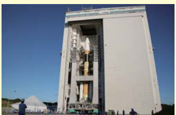
大型ロケット組立棟 (VAB)
