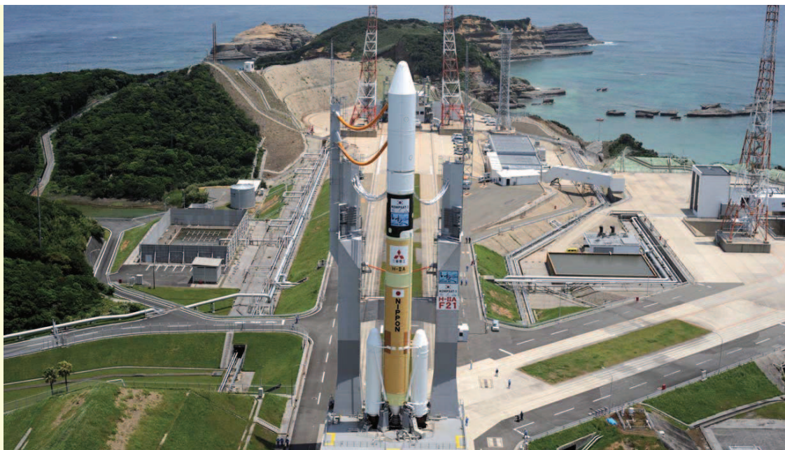
大型ロケット組立棟から見た大型ロケット発射場
