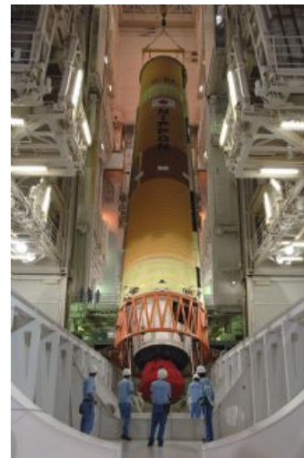
ロケットの搬入・据付
