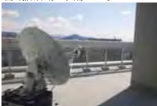
岩手県庁に設置された WINDS可搬型VSATアンテナ
