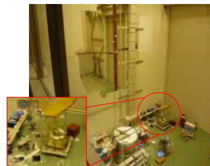
図1 13mφスペースチャンバ室の壁崩落によりクリーンルーム機能を喪失
