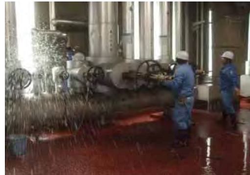
(図A) 動力棟 冷水・温水配管破損
