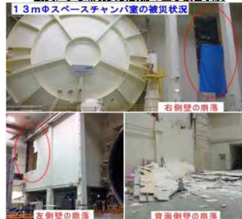
図1 13mφスペースチャンバ室の壁崩落によりクリーンルーム機能を喪失
