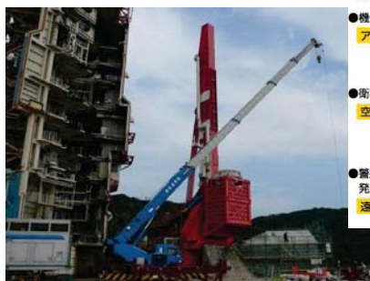
図6 ランチャの改修
