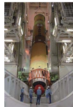
ロケットの搬入・据付
