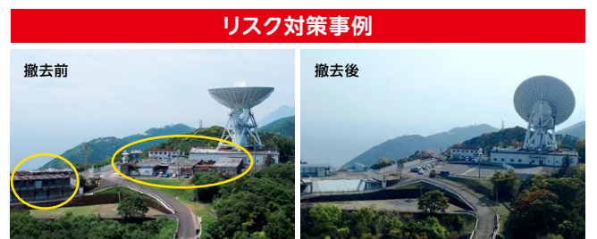
地震被害の拡大防止及び迅速な回復につながる減災対策として、内之浦宇宙観測所内の不要となった施設や耐震性に問題のある建屋(全6棟)を解体・撤去しました。継続的な震災リスクの縮減を今後も推進していきます。
