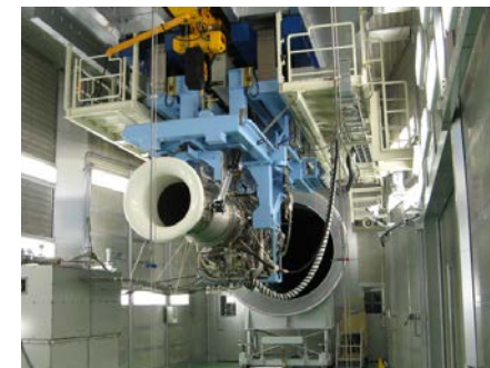
地上エンジン運転設備
