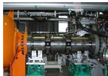
写真1 我が国唯一、高温高圧で連続燃焼試験が可能
