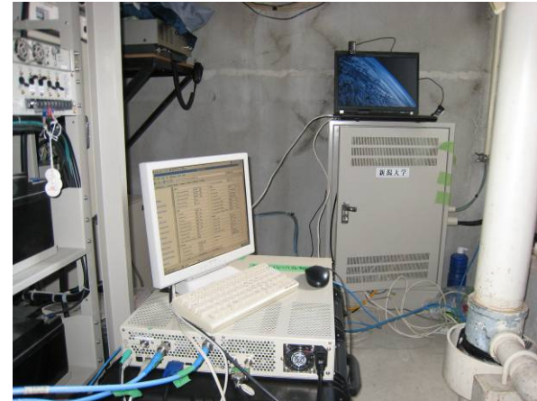
可搬型VSAT地球局 屋内機器
