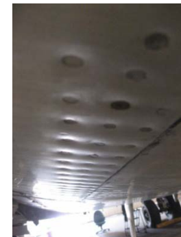
腐食により凹凸のある胴体下部のリベット継手
