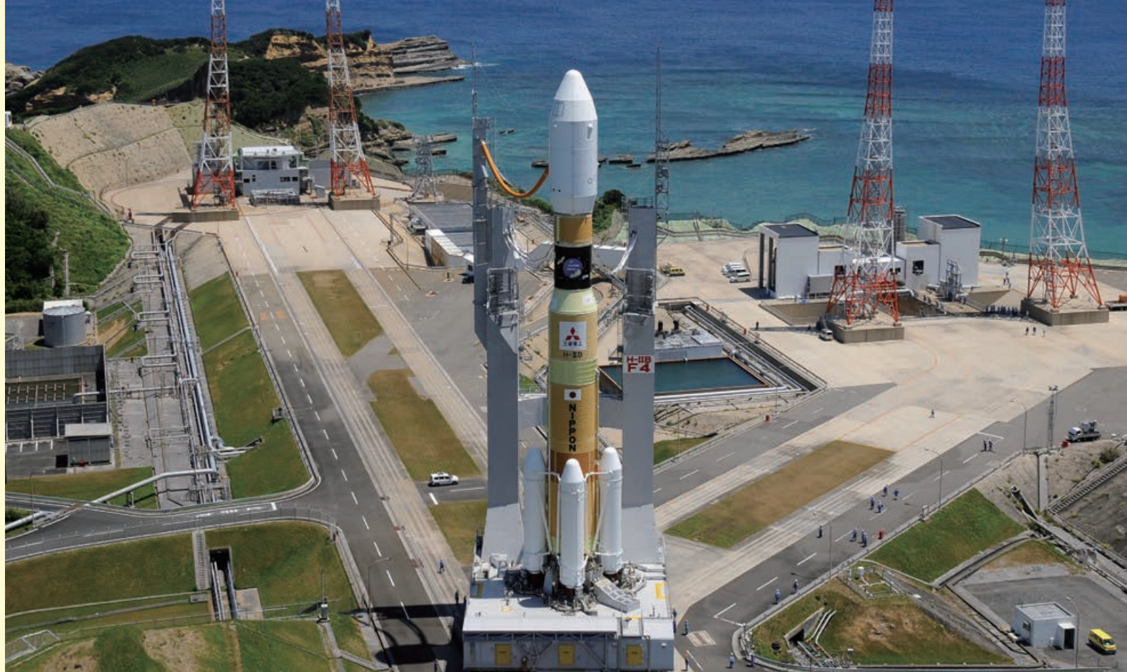
大型ロケット組立棟から見た大型ロケット発射場
