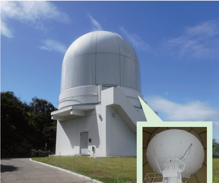
C A局テレメータ H3ロケット対応設備
