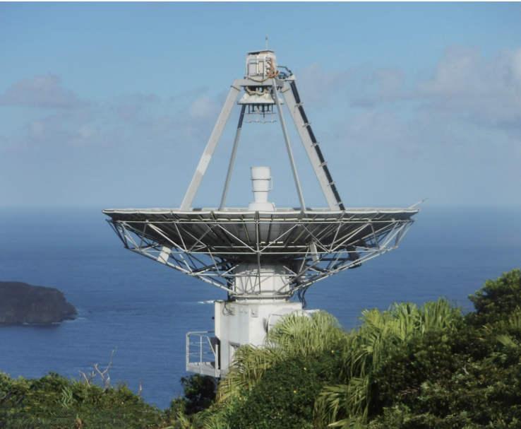
A 第1テレメータ H-IIAロケット・イプシロンロケット対応設備
