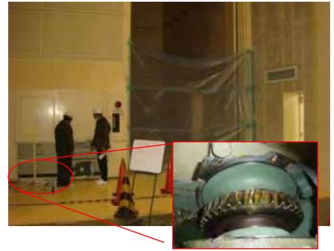
図4 音響設備 反響室扉駆動装置の破損(大扉2枚)
