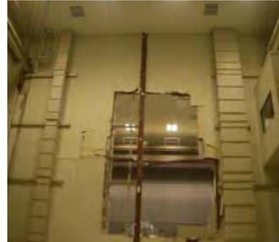
(図B) 総合環境試験棟 壁破損落下
