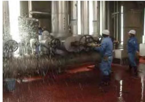
(図A) 動力棟 冷水・温水配管破損
