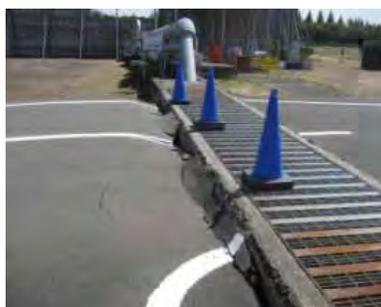
(図H) 構内道路の沈下
