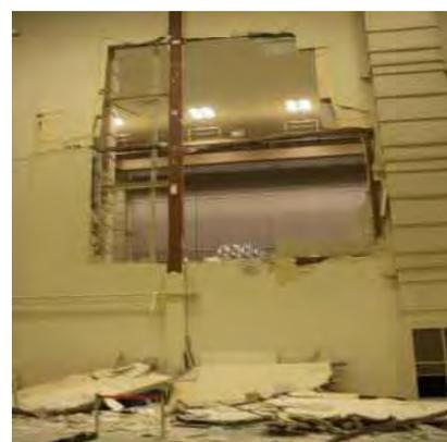
(図2) 総合環境試験棟被災状況 壁崩壊がれき
