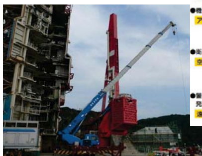
図6 ランチャの改修
