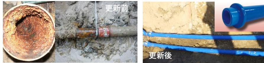
経年劣化にて、配管からの漏水事故が増加。内部配管の肉厚も薄くなっており、全面更新が必要。
