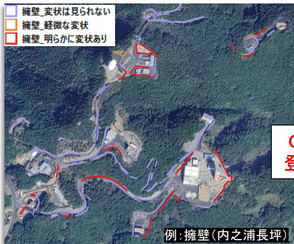
現地踏査による 構造物起因のリスク抽出の例(内之浦)
