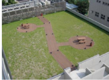
屋上緑化（総合研究棟）
