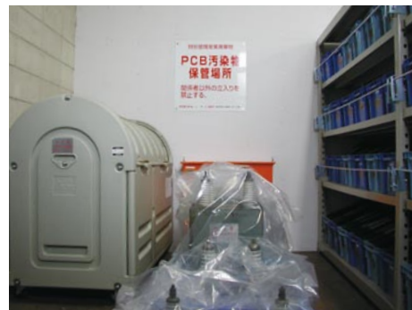
PCB保管庫内部
