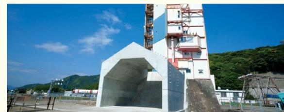
イプシロンロケット打上げ時の音響低減を目的に新設された、ロケット発射装置の煙道(三角屋根のコンクリート部分)
