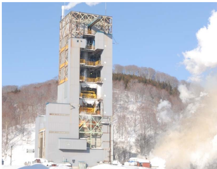
厚肉タンクステージ燃烧試験実施状況(全景)
