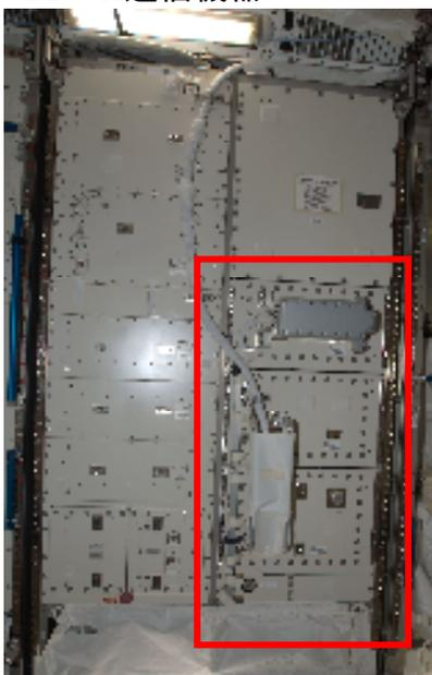
「きぼう」船内実験室の天井に設置されているICS/PROXラックの右半分(赤枠で示した部分)にPROX通信機器は搭載されています。
