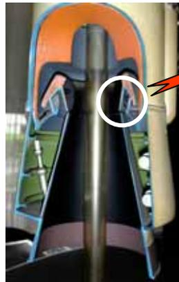
ゴムと鋼板を3次元的にリング状に積層した構造
