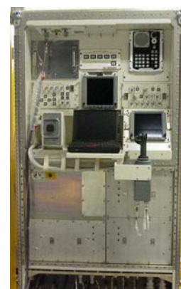
④きぼうロボットアーム制御ラック
