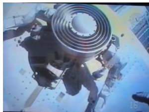
船内保管室の外壁への HTV用GPSアンテナ設置
