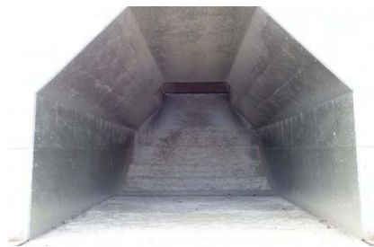
煙道の出口正面から撮影
