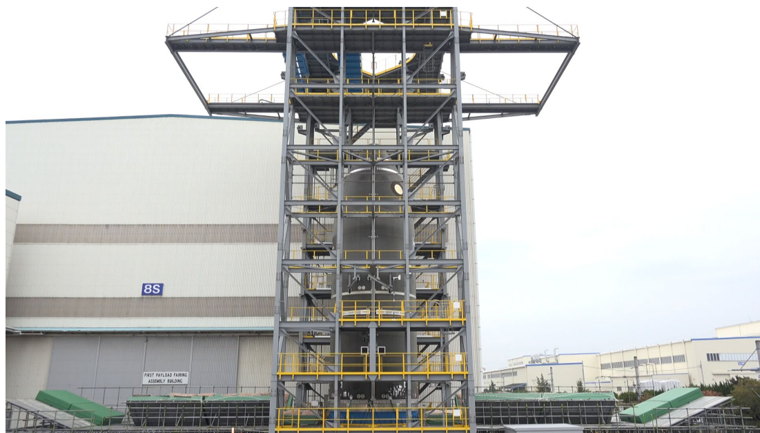
フェアリング分離放擲試験(2019.12.17)
