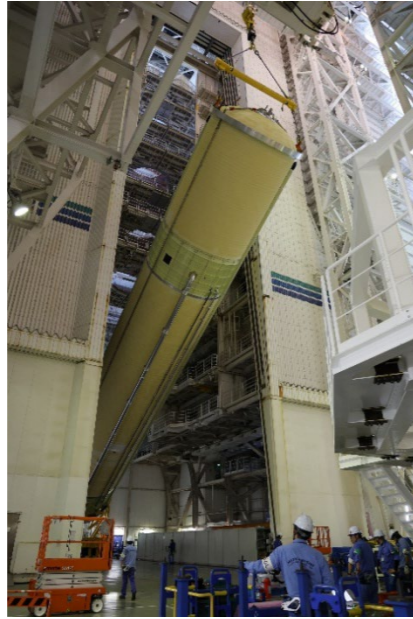
2025年8月29日 1段機体射座据付け (VOS※1)
