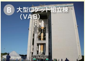
工場から搬入されたロケットを組み立て・整備・点検するための設備で、2機のロケットを並行して組み立てることができます。ロケットを移動発射台の上に組み立てていき、最後に衛星フェアリングを取り付けます。
