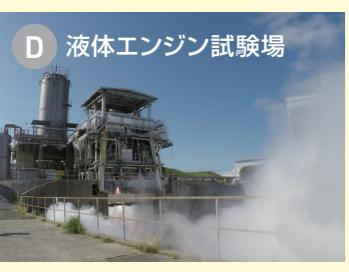
ロケットの心臓部とも言える第1段エンジンの地上燃焼試験場です。現在は、H3ロケットの第1段エンジン「LE-9」の燃焼試験を行っています。
