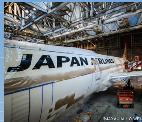
リブレット施工作業風景
