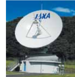
地球観測センターにある直径約13メートルのパラボラアンテナ
