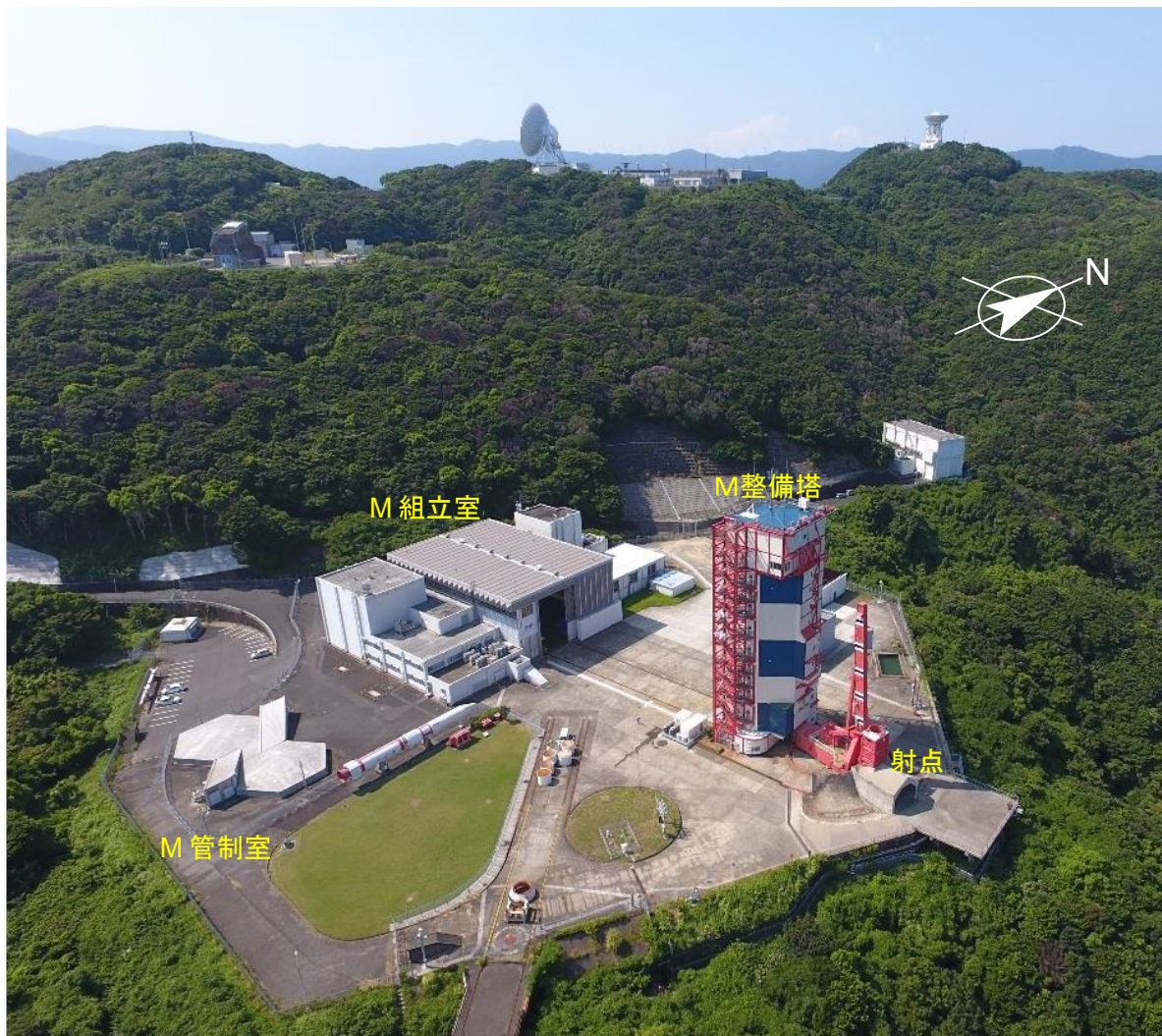
図 5.1.3-1 ロケット発射施設(M 台地)
