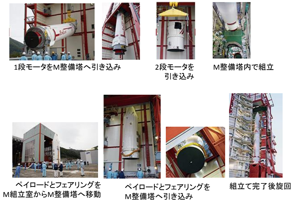
図 5.1.3-4 M 整備塔での組み立て作業
