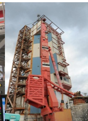
M整備塔改修
