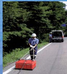
地下探査レーダーを用いた試験風景
